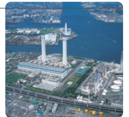
東京電力(株)横浜火力発電所<神奈川>
