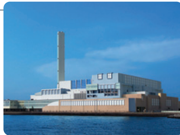
横浜市資源循環局金沢工場[廃棄物発電所] <神奈川>
